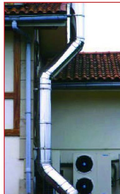
**Fabbricata in acciaio inossidabile AISI 316L nella parete interna e AISI 304 18/10 CrNi nella parete esterna con isolamento di 25 mm di spessore, alta densità.**
